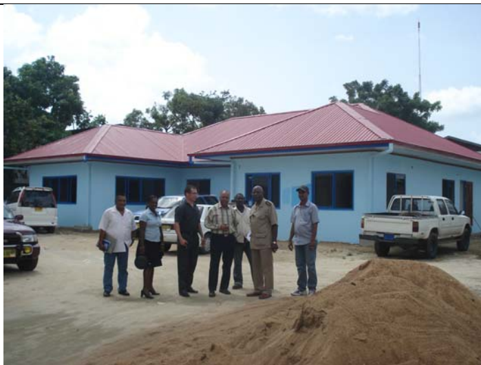
HET IDS/WAN-gebouw. 11-06-2009 sleutelklaar opgeleverd. fully loaded: meubilair, equipment, WAN-centrale. Het wachten is op aansluiting van electra door EBS
